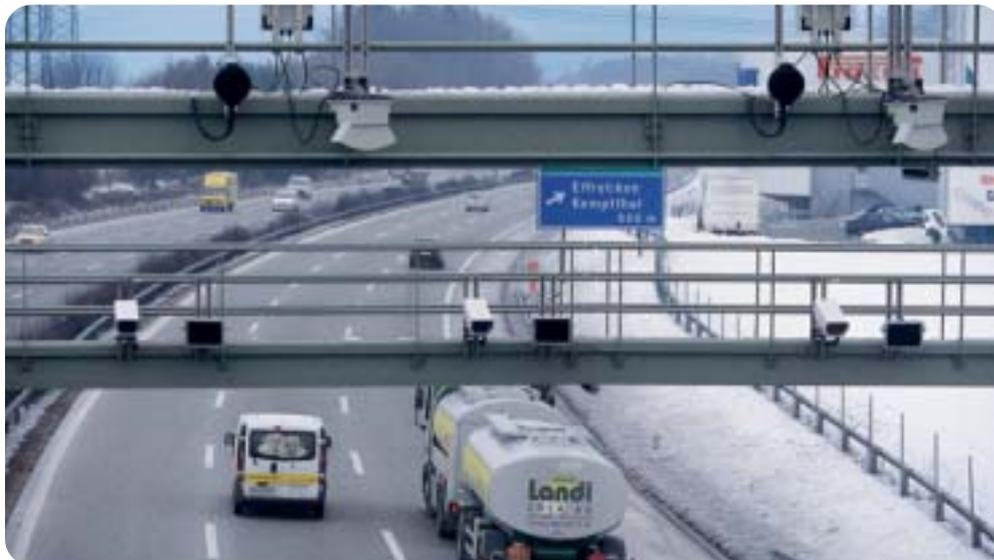
**21 dieser LSVA-Messstationen werden dieses Jahr auf Schweizer Autobahnen installiert. Laser-scanner erfassen die Kennzeichen von Lastwagen. Immer wieder kommt es nämlich vor, dass bei der zurückgelegten Distanz oder den Anhängerdaten falsche Angaben gemacht werden.**
